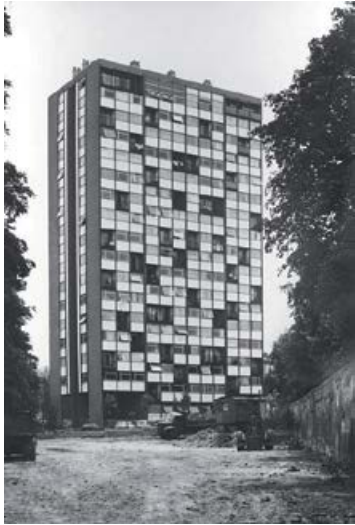
1959-1961 Progettata dall'architetto Raymond Lopez, è stato il primo edificio a torre a sorgere nell'urbanizzazione del XVII arrondissement. Il metodo costruttivo si basava sull'assemblaggio di elementi prefabbricati su una maglia di cemento modulare, un sistema diffuso a grande scala nel secondo dopoguerra.
