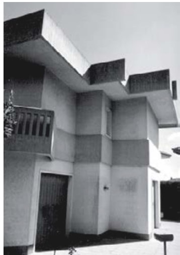
foto: prima e durante la demolizione
