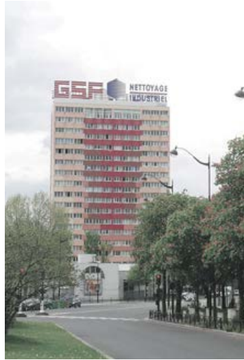
1990 Una prima trasformazione viene realizzata attraverso l'installazione in facciata di un rivestimento isolante che chiude le logge e riduce le aperture a piccole finestre, con una riduzione dell'illuminazione naturale interna e delle viste sulla città.
