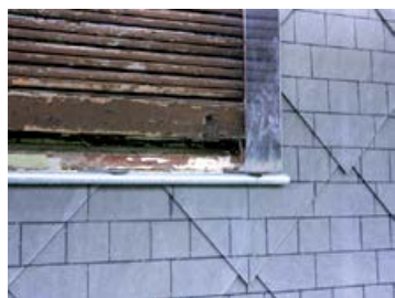
Per riprendere il motivo della parete originaria, viene ridisegnato sui pannelli a scandole l'orditura in mattoni.
